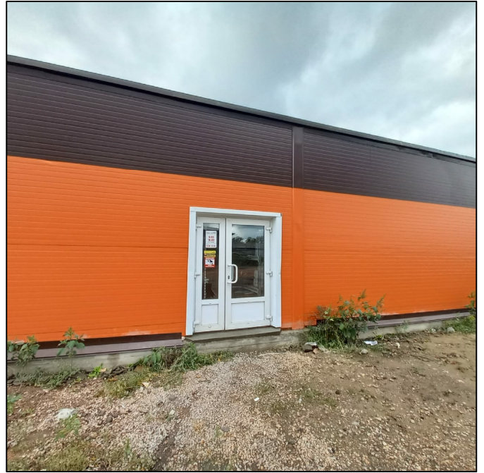
Вид с восточной стороны.
