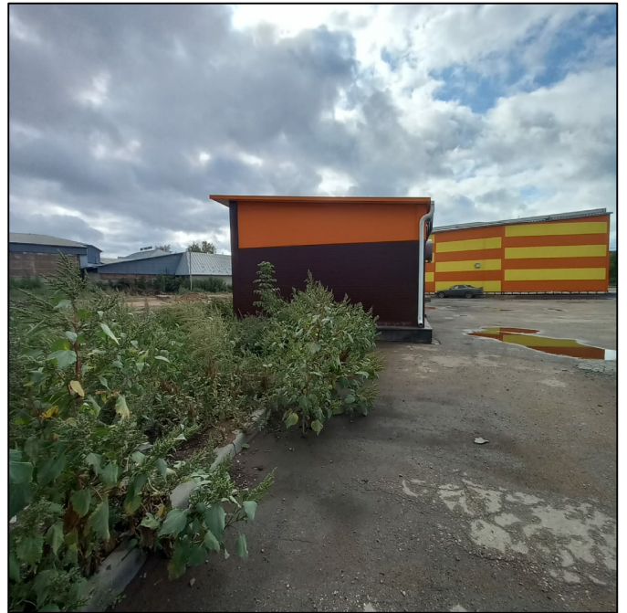
Вид с северной стороны.
